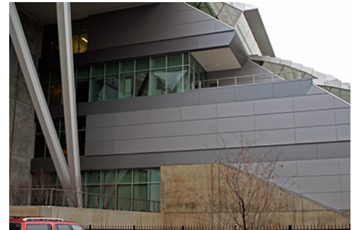
VAI Finish88_exterior:north elevation.j...
