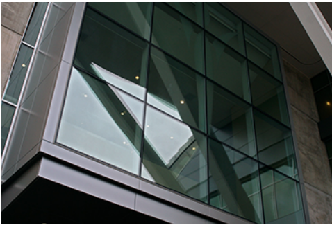
VAI Finish90_exterior:Angel wall detail...
